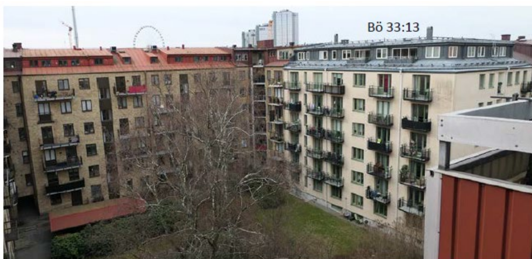
Figur 8. Foto av Antiquum, taklyft indraget från takfoten på Bö 33:13.
