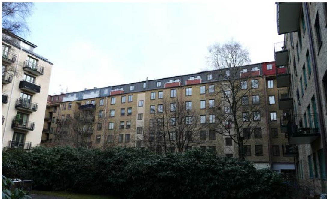
Figur 9. Foto av Antiquum. Taklyft på de östra delarna av kvarteret Skålnäcken som inte är indraget från takfoten.
